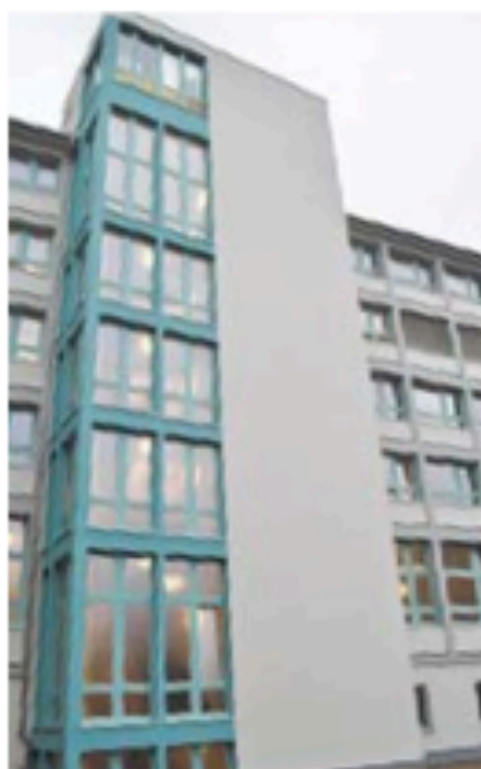
Denkmalgerecht saniert: das Haus C des Kriminalgerichts Moabit.
