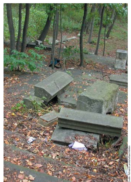
Die Haupttreppe. Zustand 2005
